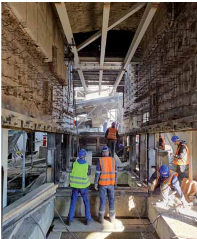
Rekonstrukcija hladnjaka klinkera i zamena multiciklonskog otprašivača
